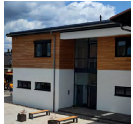
Außenansicht des neuen Bürogebäudes
